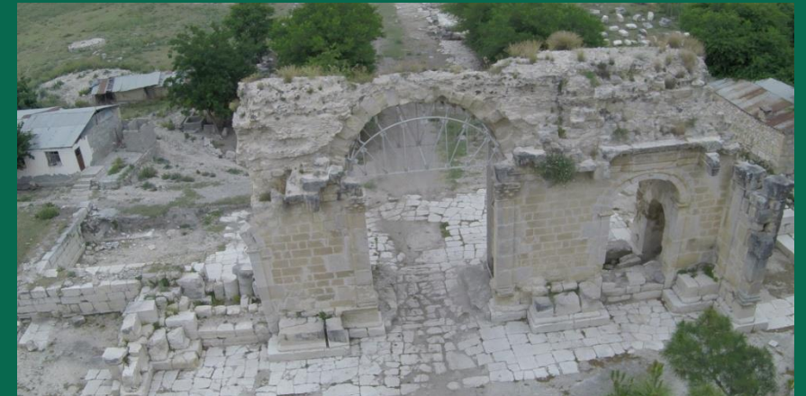
Geney (Ala Kapı) Cephe Görünüşü 2017
